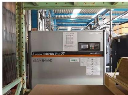
図4 インバータ式コンプレッサ
