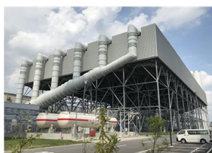
空気冷却式復水器
