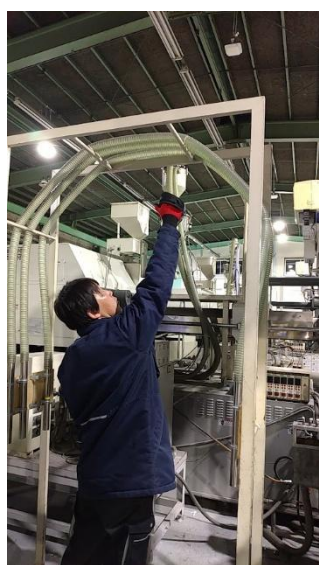
図 6 エア漏れ計測作業
