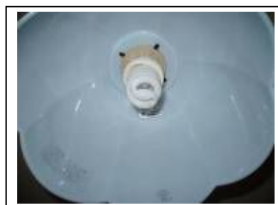
蛍光灯への交換
