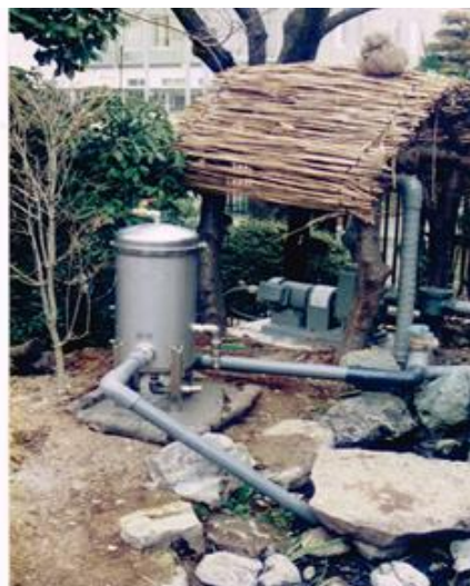
写真5 バイオテクノロジー緑化工法
