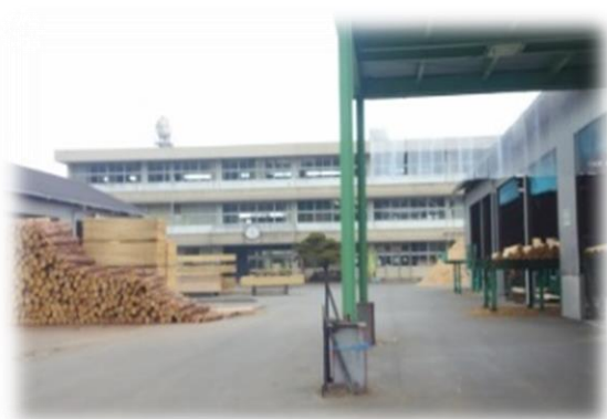
写真1 廃校を利用した製材所
