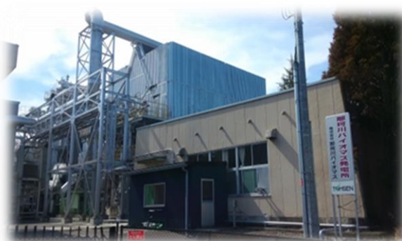
写真2 バイオマス発電所
